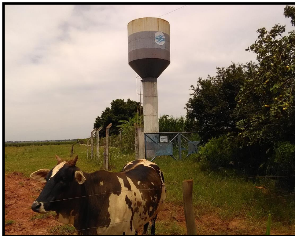
Imagem 23: Reservatório da Vila rural
