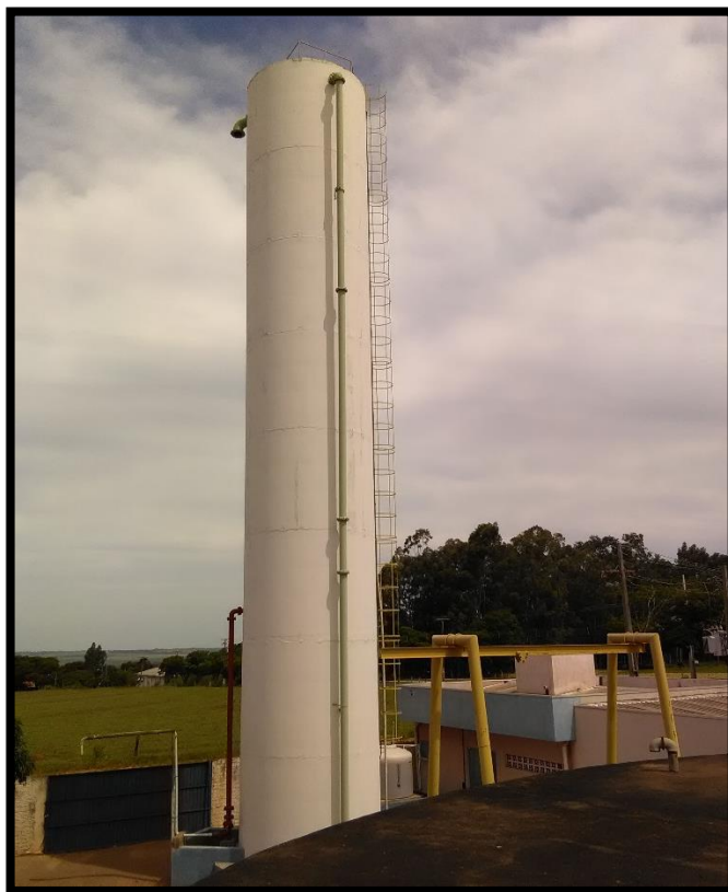
Imagem 20: Reservatório elevado do Sistema Sede
