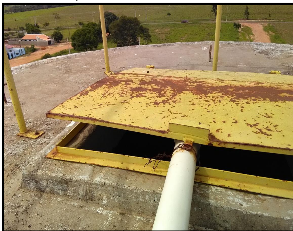
Imagem 21: Abertura de inspeção do Reservatório elevado do Sistema Sede
