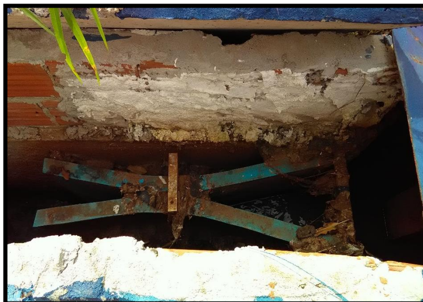
Imagem 32: Medidor de Vazão
