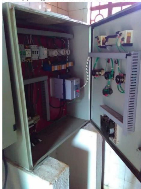
Foto 08 – Quadro de comando bomba do poço
