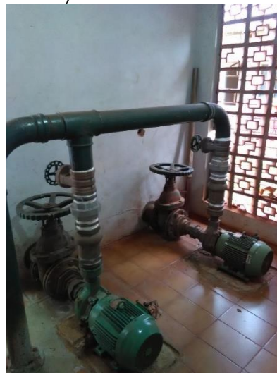
Foto 40 – Frente quadro de recalque (água tratada)
