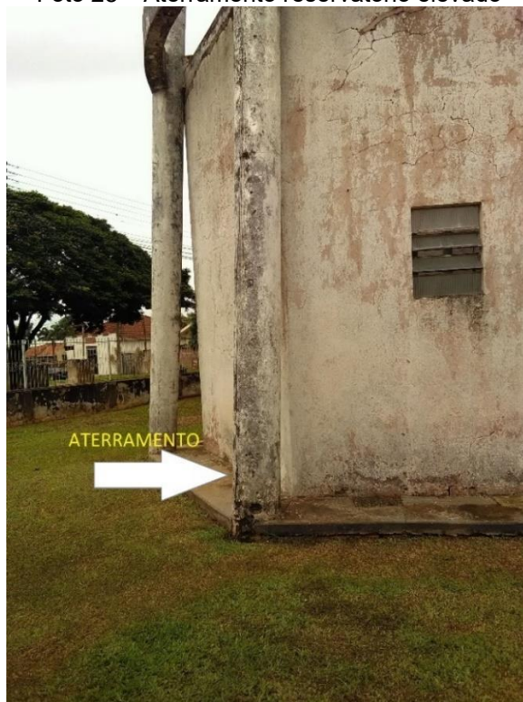
Foto 28 – Aterramento reservatório elevado
