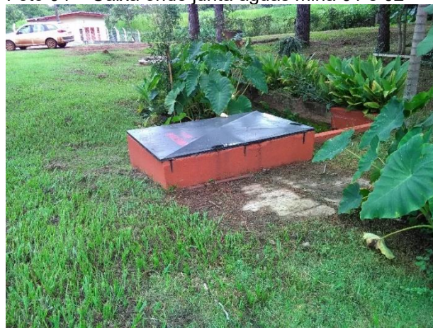
Foto 04 – Caixa onde junta águas mina 01 e 02
