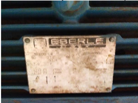
Foto 31 – Identificação bomba de recalque
