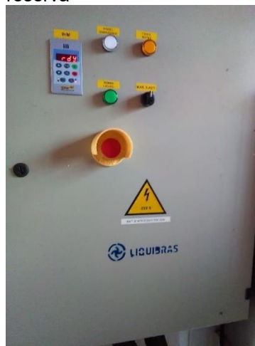
Foto 34 – Frente quadro bomba recalque reserva
