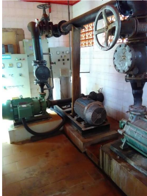
Foto 30 – Bombas de recalque (foto 02)
