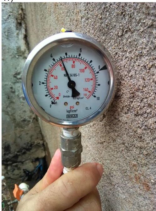
Foto 53 – Medição de pressão na rede: Rua Santos Dumont, nº. 87 – P=64 mca (23° 42'52.1"S; 51° 38. '46.5"W)
