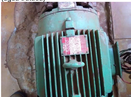
Foto 39 – Identificação bomba recalque (água tratada)
