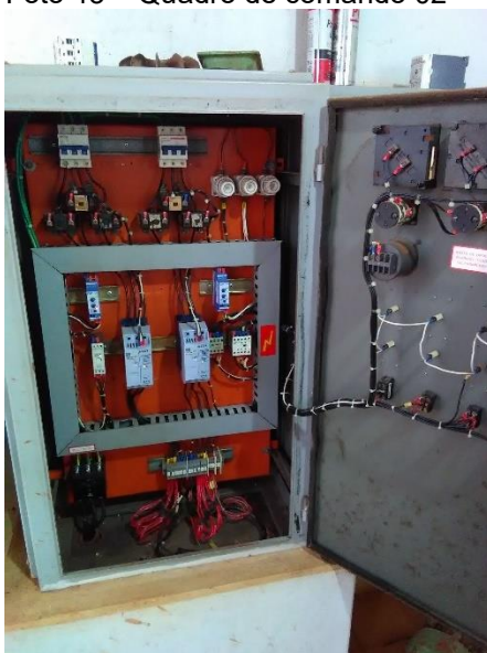
Foto 43 – Quadro de comando 02
