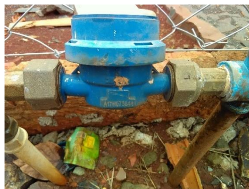
Foto 46 – Hidrômetro Rua São Paulo, lote 20-C-1-9 (23°42'52.1"S; 51° 38'12.20" W)
