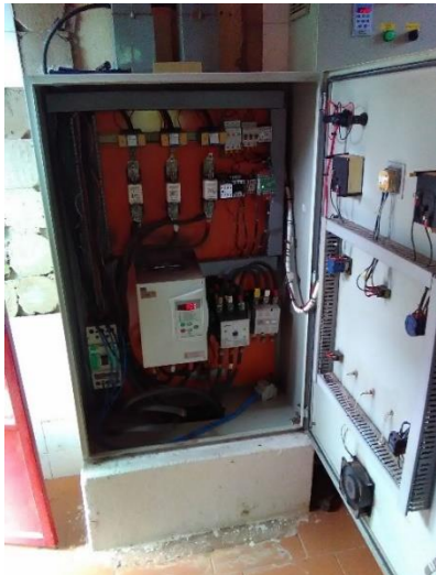
Foto 35 – Quadro da bomba de recalque reserva
