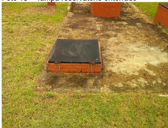
Foto 19 – Tampa reservatório enterrado
