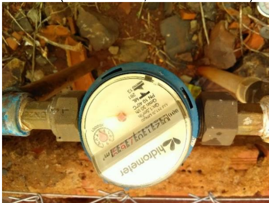
Foto 45 – Hidrômetro Rua São Paulo, lote 20-C-1-9 (23°42'52.1"S; 51° 38'12.20" W)
