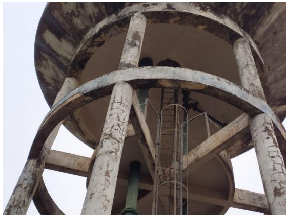
Foto 27 – Detalhe reservatório elevado
