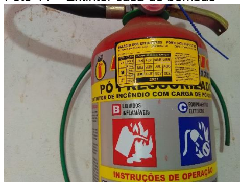
Foto 44 – Extintor casa de bombas
