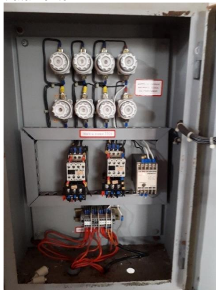
Foto 15 – Quadro de comando da unidade de tratamento
