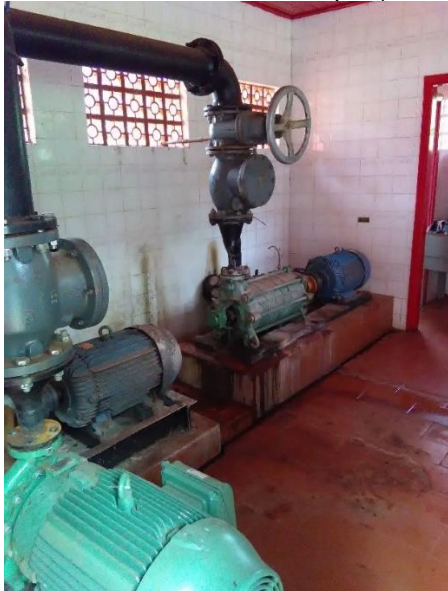
Foto 29 – Bombas de recalque (foto 01)
