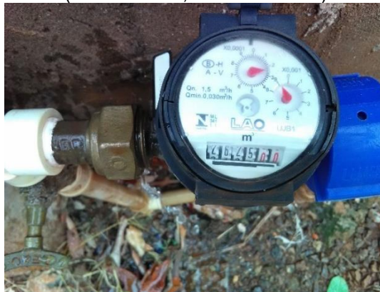
Foto 51 – Hidrômetro Rua Santos Dumont, nº. 87 (23°42'52.1"S; 51° 38. '46.5"W)
