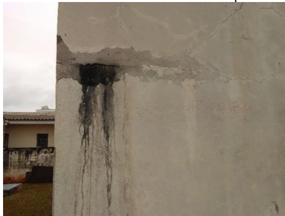
Foto 23– Fissuras reservatório apoiado
