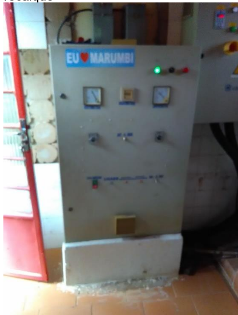
Foto 32 – Frente do quadro da bomba de recalque
