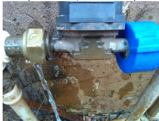
Foto 52 – Hidrômetro Rua Santos Dumont, nº. 87 (23°42'52.1"S; 51° 38. '46.5"W)
