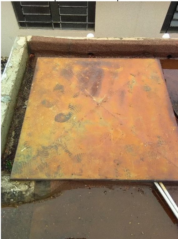
Foto 24 – Tampa reservatório apoiado
