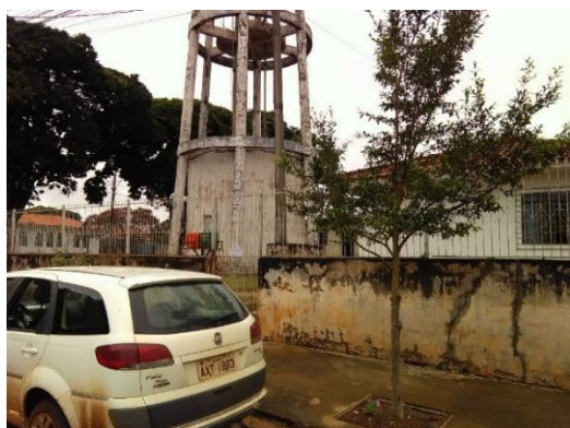
Foto 01 – Fachada área comercial
