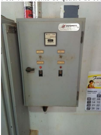
Foto 41 – Frente do quadro de comando 02
