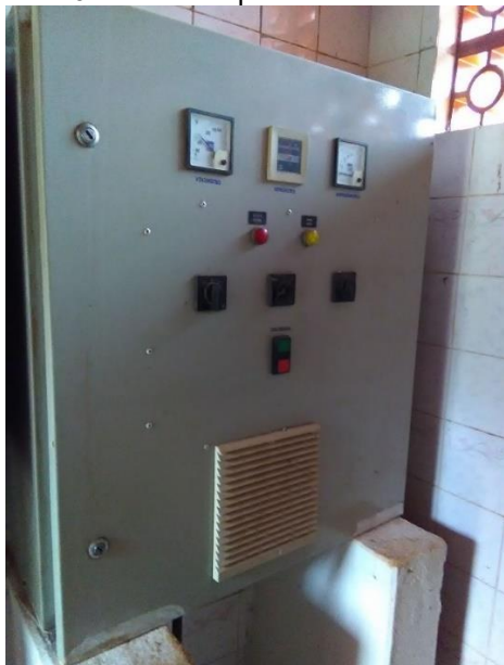
Foto 07 – Frente quadro de comando bomba poço
