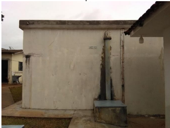
Foto 22 – Canalizações reservatório apoiado
