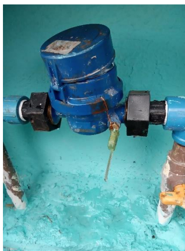
Foto 144 – Medição pressão na rede P02 – P = 114 mca
