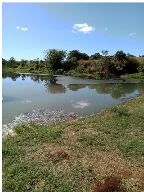
Foto 188 – Lagoa anaeróbia ETE Ribeirão Sarandi
