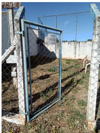
Foto 102 – Acesso e identificação UTA Parque das Palmeiras
