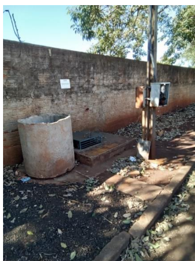
Foto 12 – Isolamento Poço Planalto Chão
