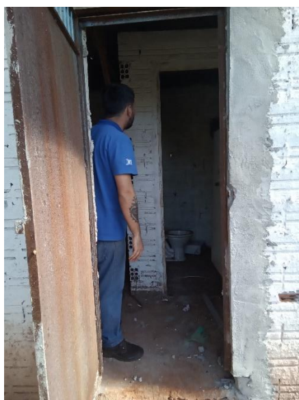
Foto 204 – Limpeza e conservação EE Jardim Itália
