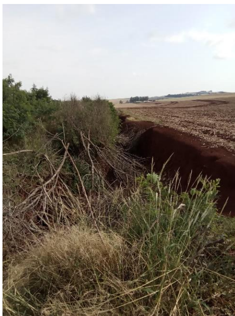
Foto 194 – Erosão ao lado ETE Damasceno
