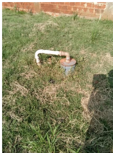
Foto 96 – Falta de isolamento poço Cambui
