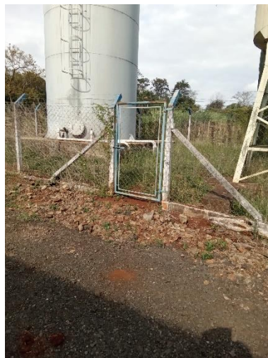
Foto 153 – Acesso e manutenção REL Cambui
