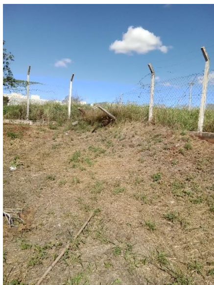
Foto 196 – Isolamento elevatória Parque Industrial
