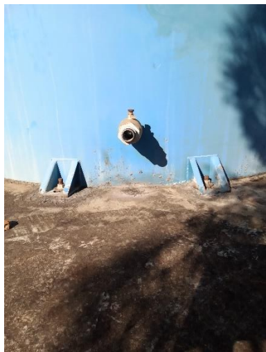
Foto 147 – Extravasador REL CSU
