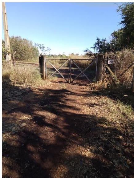
Foto 160 – Falta de placa de identificação ETE Aquidaban
