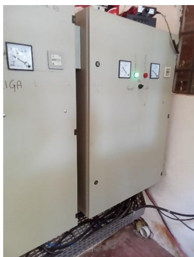
Foto 79 – Frente quadro de comando mina adutora 1
