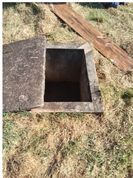
Foto 165 – Saída primeira lagoa anaeróbia ETE Aquidaban
