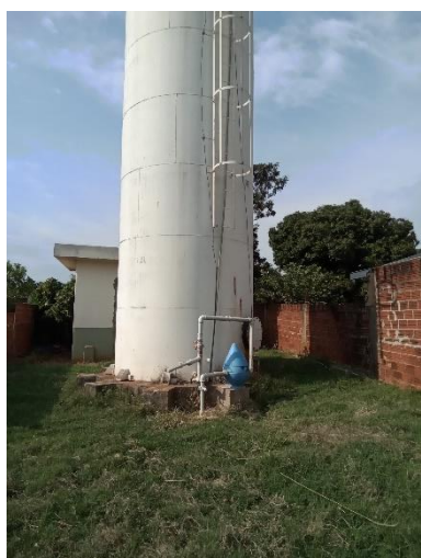
Foto 151 – Aterramento e escada REL Damasceno
