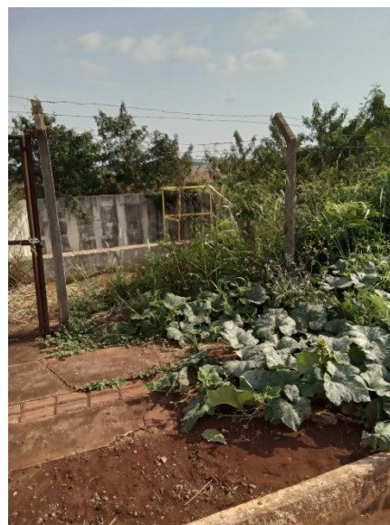
Foto 191 – Entrada ETE Damasceno
