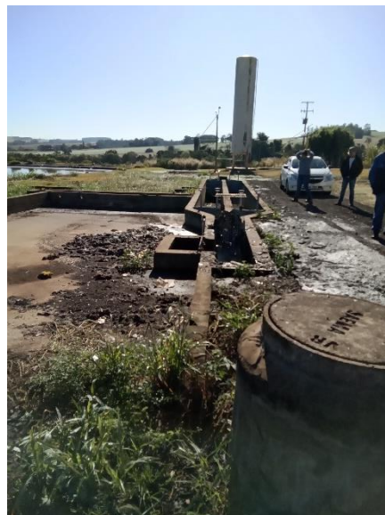
Foto 161 – Indícios de extravasamento de esgoto sanitário
