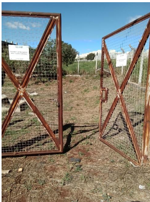
Foto 195 – Entrada elevatória Parque Industrial
