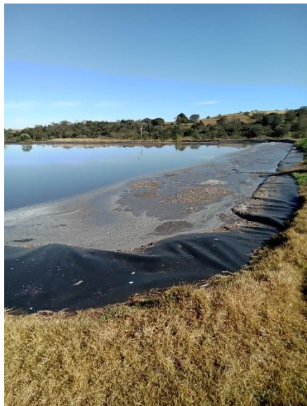
Foto 166 – Lagoa anaeróbia 02 (excesso material sobrenadante) ETE Aquidaban
