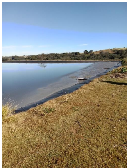
Foto 164 – Entrada primeira lagoa anaeróbia ETE Aquidaban
