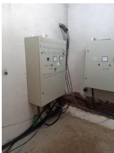
Foto 67 – Casa de comando mina adutora 2
